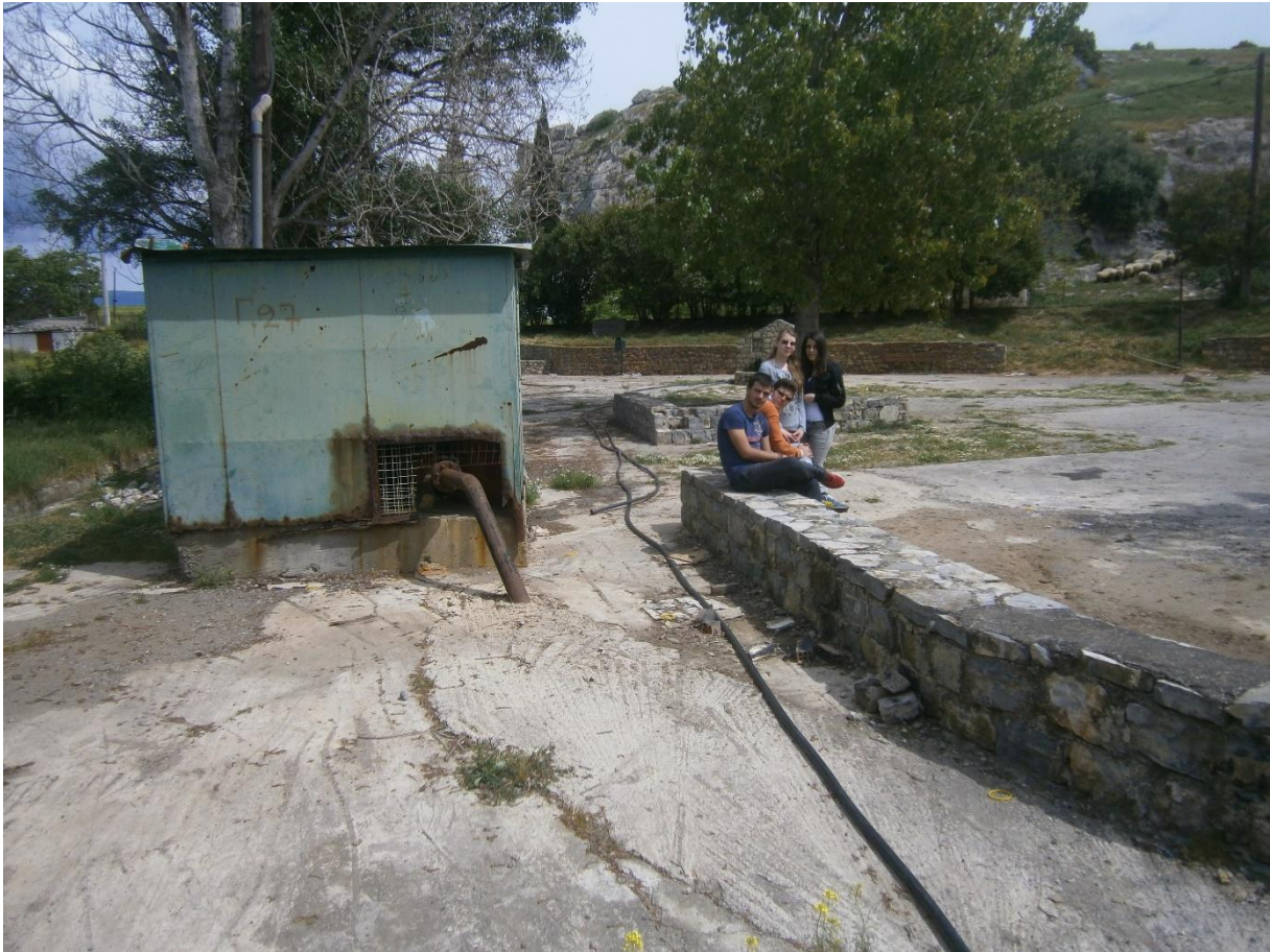
Εικόνα 9 : Στην υδρευτική γεώτρηση του Άρματος
